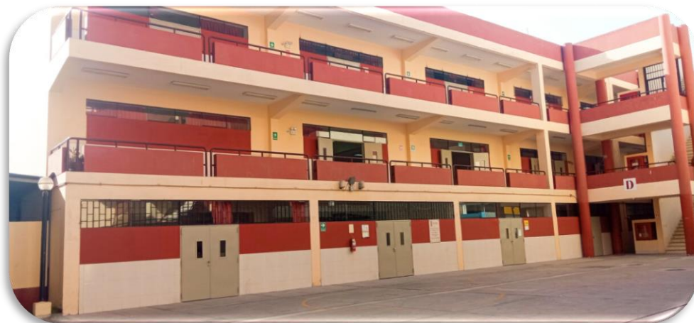
Laboratorios - Facultad de Ingeniería Industrial y de Sistemas
