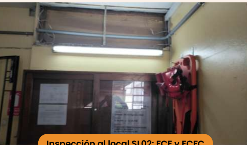
Inspección al local SL02: FCE y FCFC
